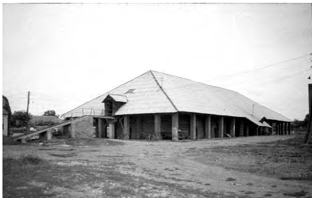
Fig. 1. Clădirea Fabricii de cărămidă , situată pe partea dreaptă a drumului ce duce spre Curtuișeni. Imagine surprinsă cu ocazia unei vizite pe teren, în vara anului 1996 [Colecția MȚC (a)].
