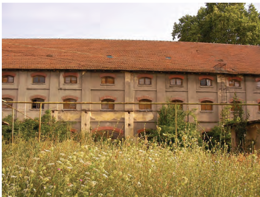
Fig. 1. Clădirea Oficiului Monopolului Tutunului (reproducere după RU 2012)
